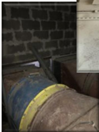
Отсутствие герметичности на вентиляционном коробе
